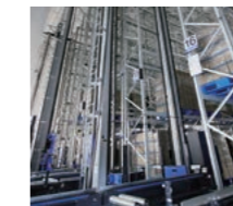
Logistiksysteme/ Fabrikautomatisierungssysteme - Automatisierte Lager- und Bereitstellungssysteme (AS/RS) - Sortiersystem
