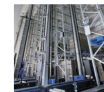
Sistemas logísticos/ sistemas de automação de fábrica -Sistemas de armazenamento e recuperação automatizados (AS/RS) -Sistema de triagem
